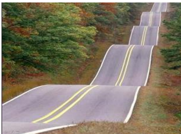
figura 1.4. Exemplos de estradas acompanhando a topografia (terreno ondulado e terreno montanhoso)
