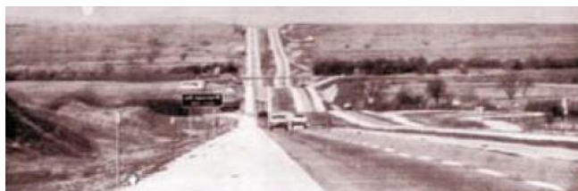
figura 1.113. Trainéis longos ligados por curvas verticais de pequeno raio produzem um mau efeito visual: tornar as curvas horizontais e verticais coincidentes
