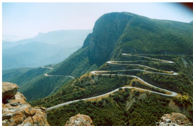
figura 1.4. Exemplos de estradas acompanhando a topografia (terreno ondulado e terreno montanhoso)
