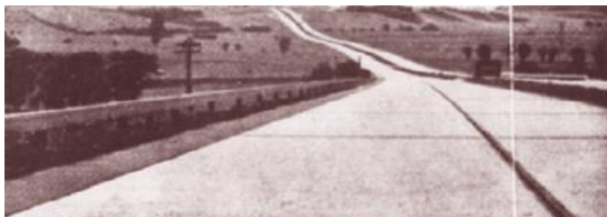
figura 1.111. Exemplo de efeito óptico causado por uma curva horizontal numa depressão: ajustar ambas as curvas
